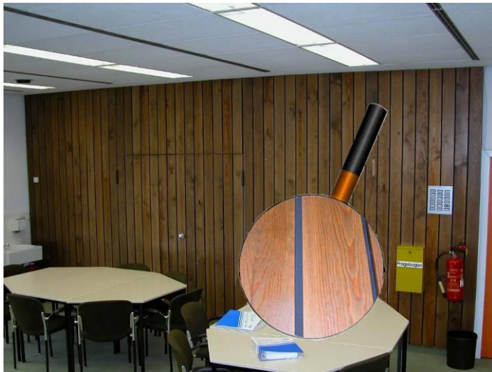
Schallabsorber aus Holzriemen mit Luftspalten
