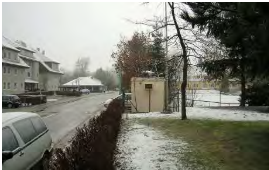
Abbildung 49: S418, Ansicht Richtung Westen
