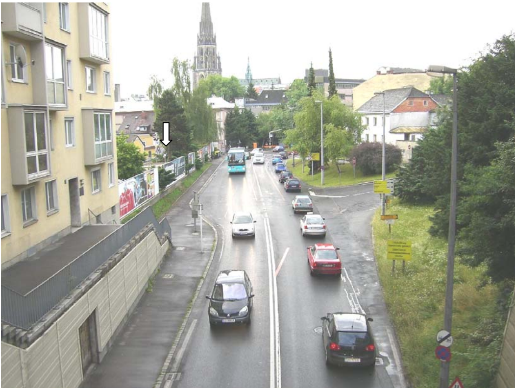
Abbildung 30: Foto Station Römerberg Richtung Süden
