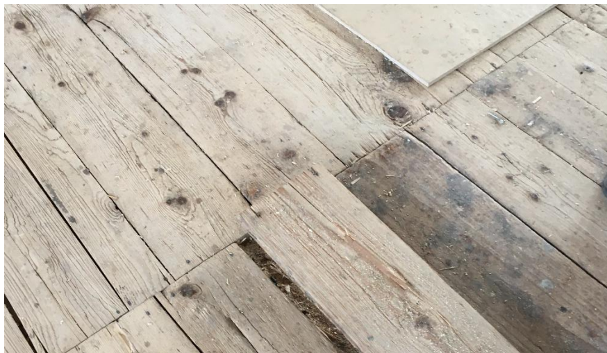
Abbildung 5: Detail: Industrieholzboden im ersten Obergeschoss © teamwork
