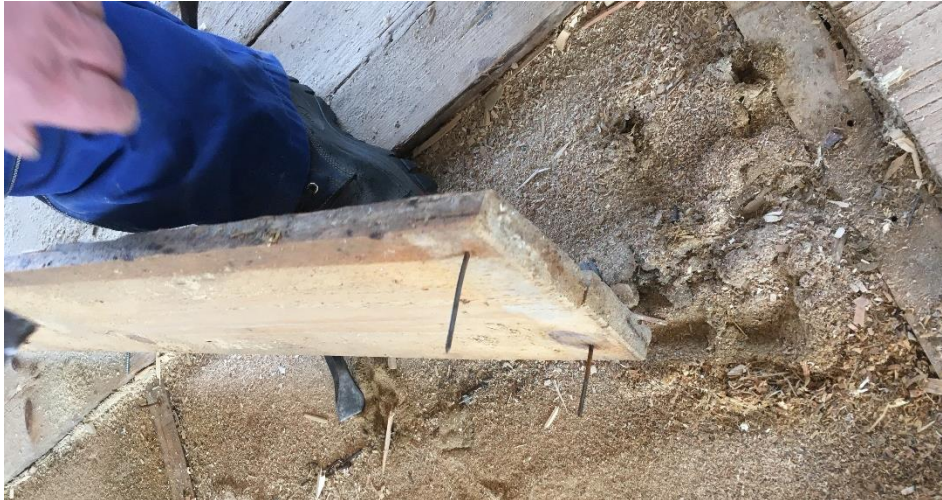
Abbildung 7: Detail: Holzbrett demontiert © teamwork
