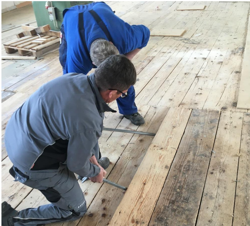
Abbildung 6: Demontageversuch Holzboden © teamwork
