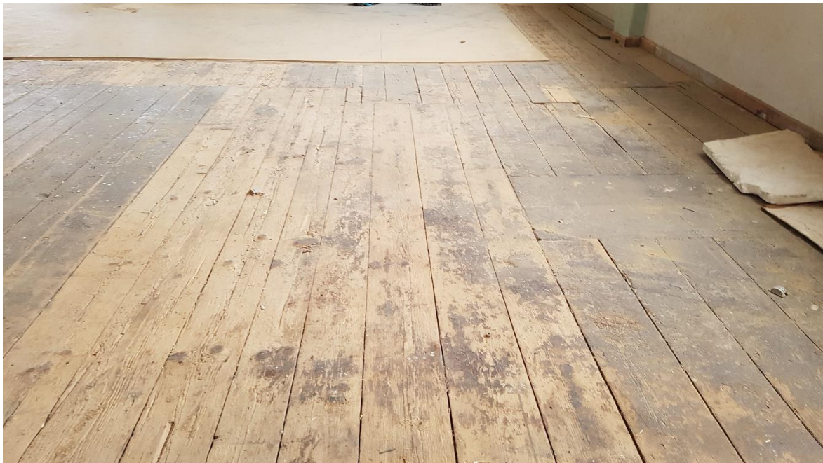
Abbildung 4: Industrieholzboden im ersten Obergeschoss © BauKarussell
