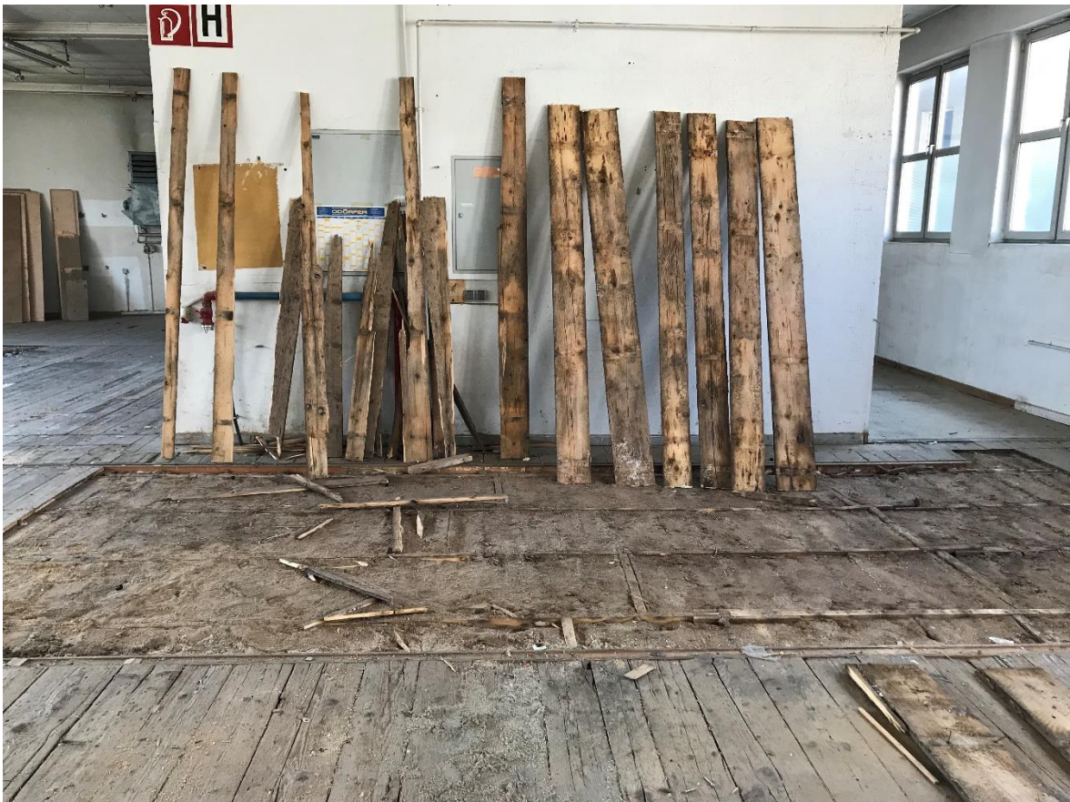
Abbildung 12: demontierte Bodenbretter © teamwork
