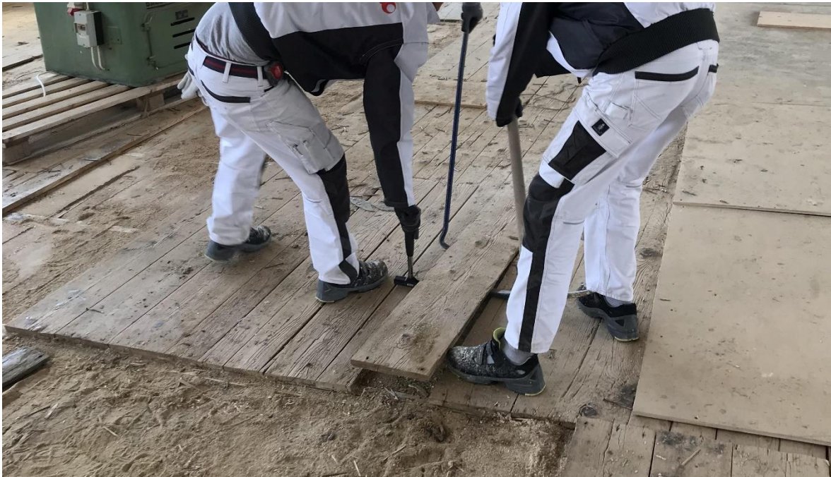
Abbildung 11: Ausbaurbeiten durch teamwork © teamwork
