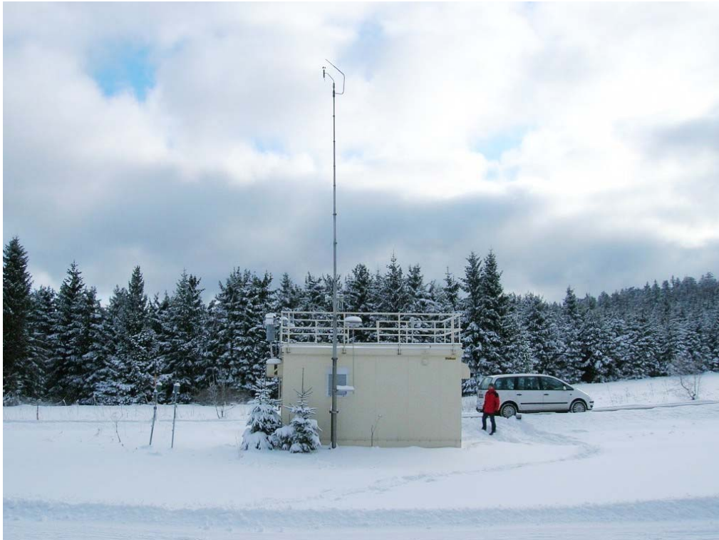
Abbildung 5: S420 Blick nach Osten (2007)
