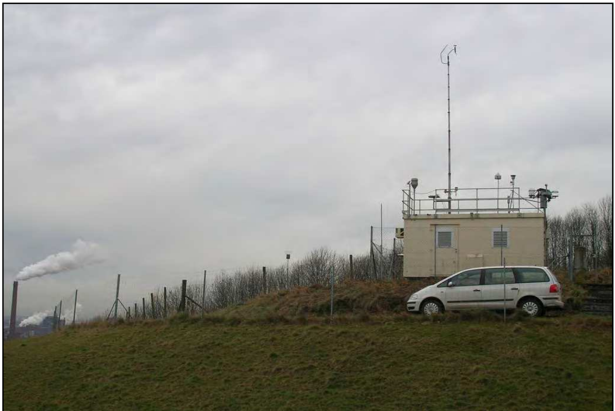
Station Steyregg-Weih, Ansicht Richtung Westen Aufnahme datum 22.1.2007
