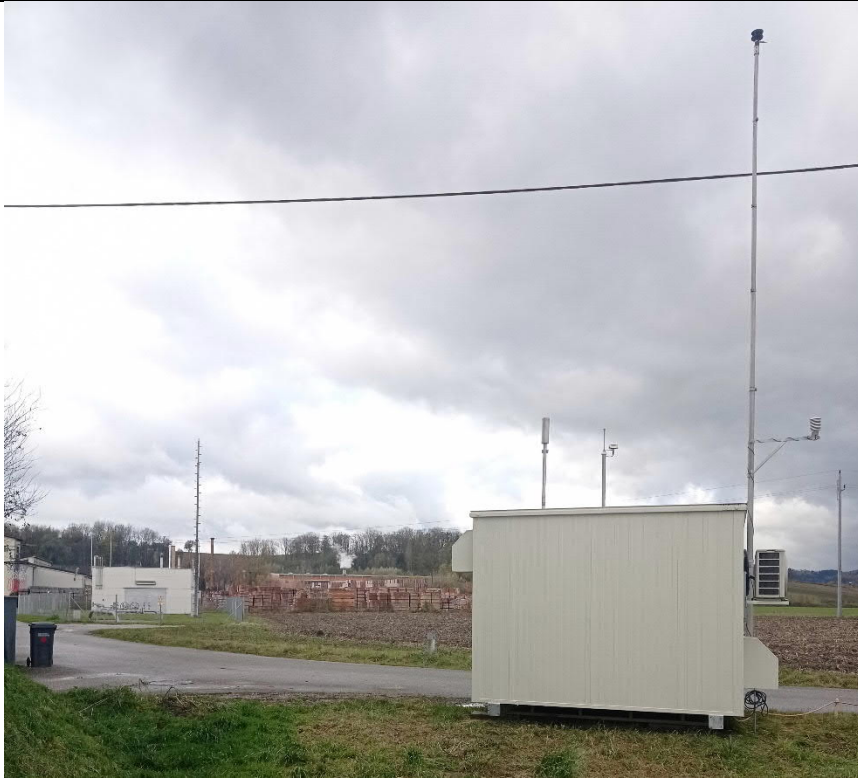
Aufnahmedatum: 13.11.2023 in Richtung West
