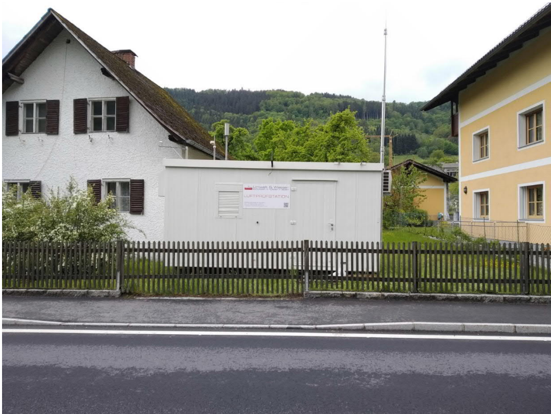
Abbildung 3: Messstelle S257 in westliche Richtung (Aufnahmedatum: 16.05.2019)
