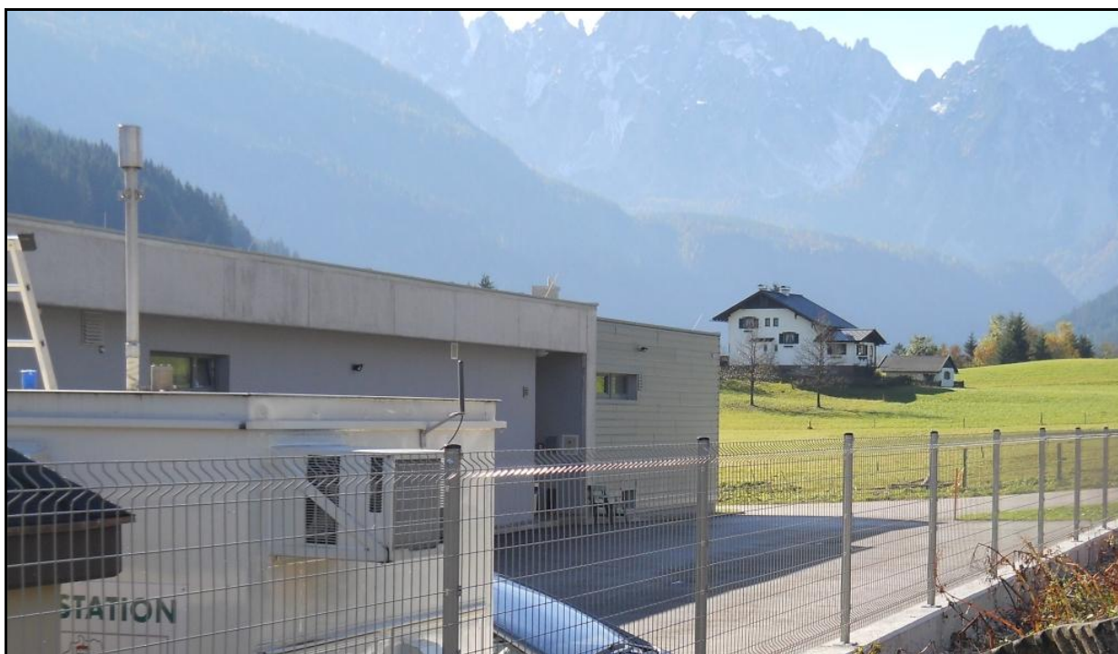
Abbildung 4: Messstelle S228 in südwestlicher Richtung
