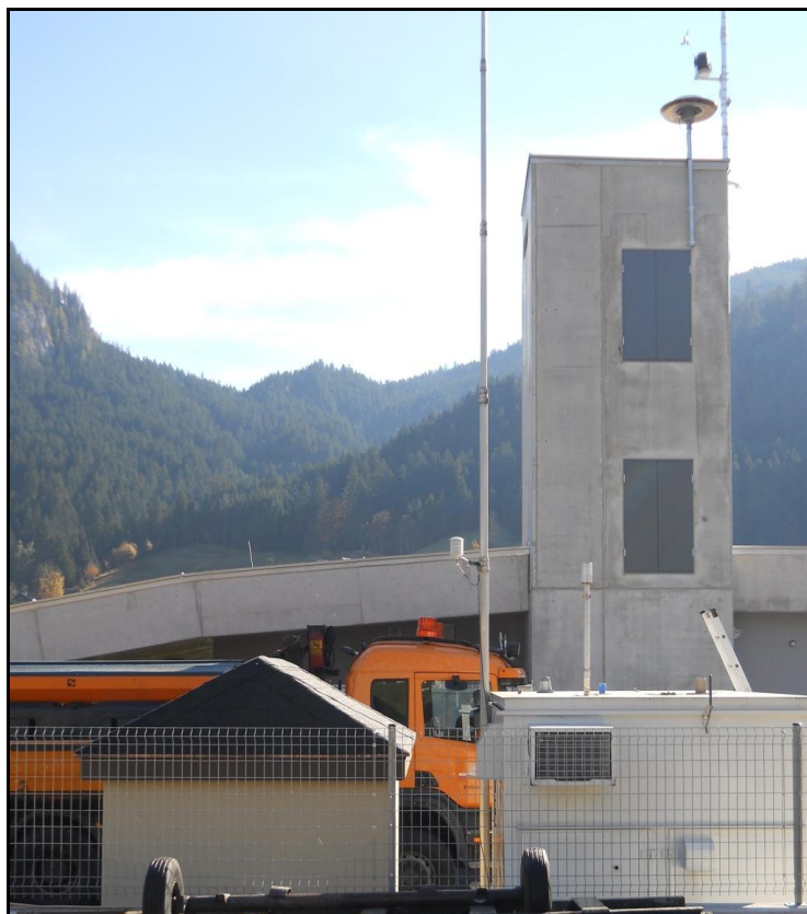
Abbildung 4: Messstelle S228 in östlicher Richtung
