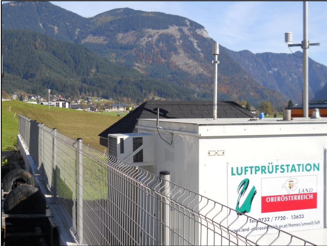
Abbildung 3: Messstelle S228 in nordöstlicher Richtung
