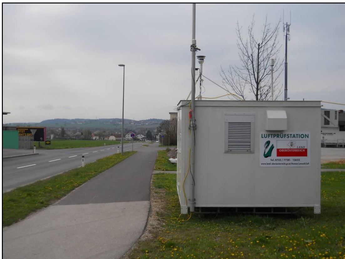
Abbildung 4: Messstelle S220 in südlicher Richtung
