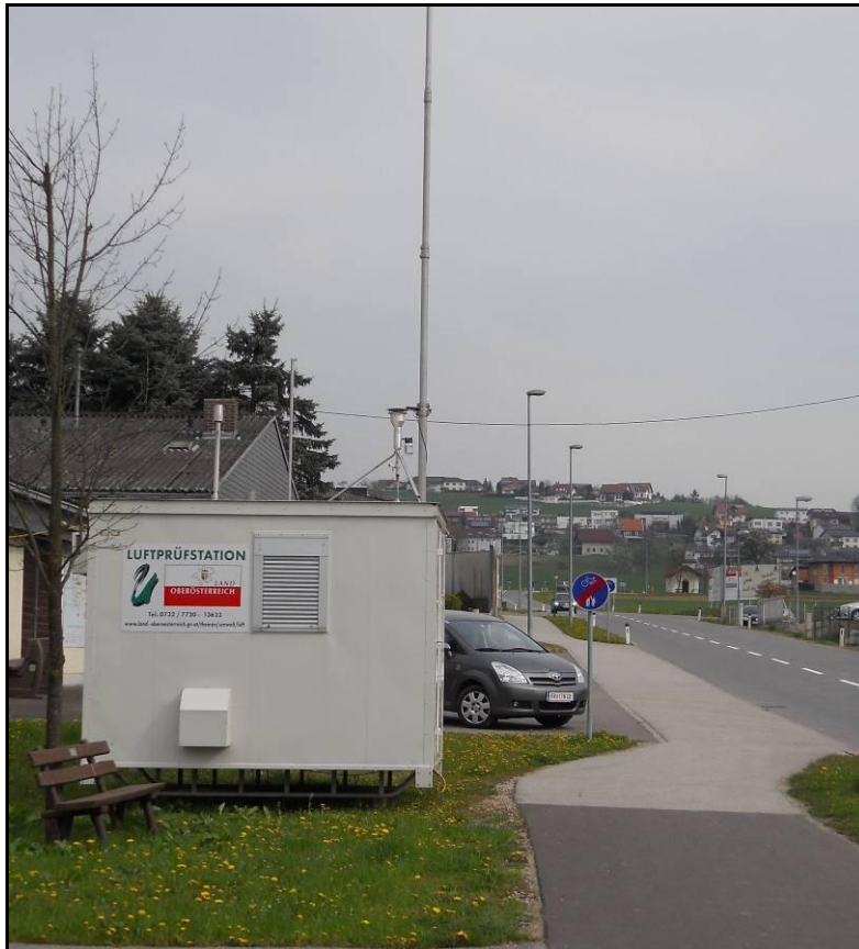
Abbildung 3: Messstelle S220, in nördlicher Richtung
