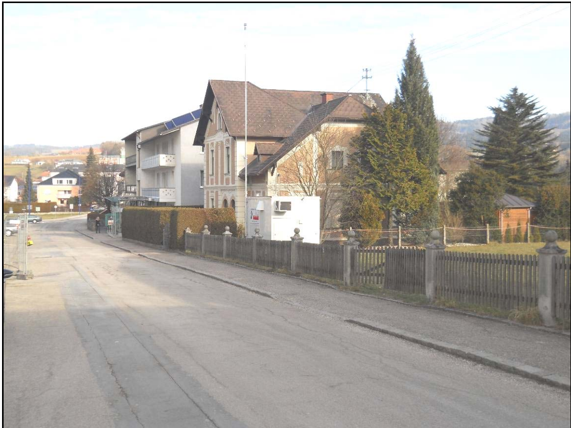
Abbildung 3: Messstelle S218, in nördlicher Richtung
