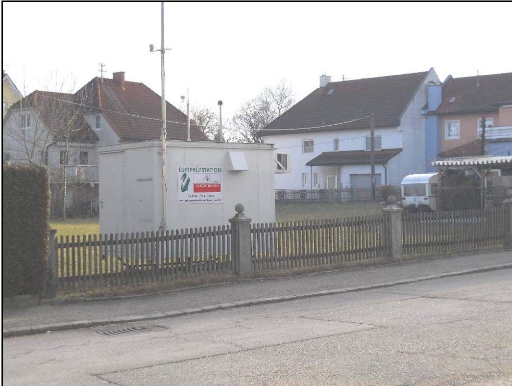
Abbildung 5: Messstelle S218 in südöstlicher Richtung
