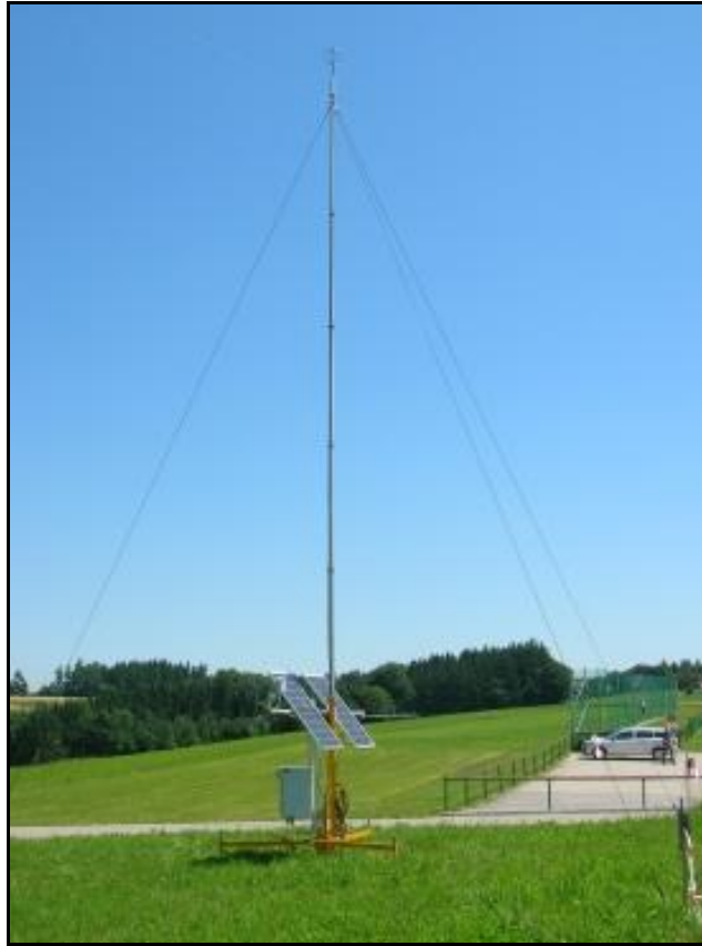
Abbildung 3: Messstelle S203, in östlicher Richtung
