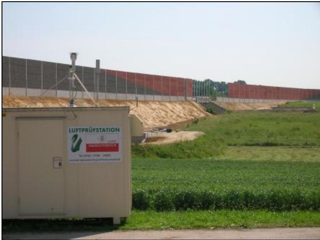
Abbildung 5: Messstelle S204 in östlicher Richtung
