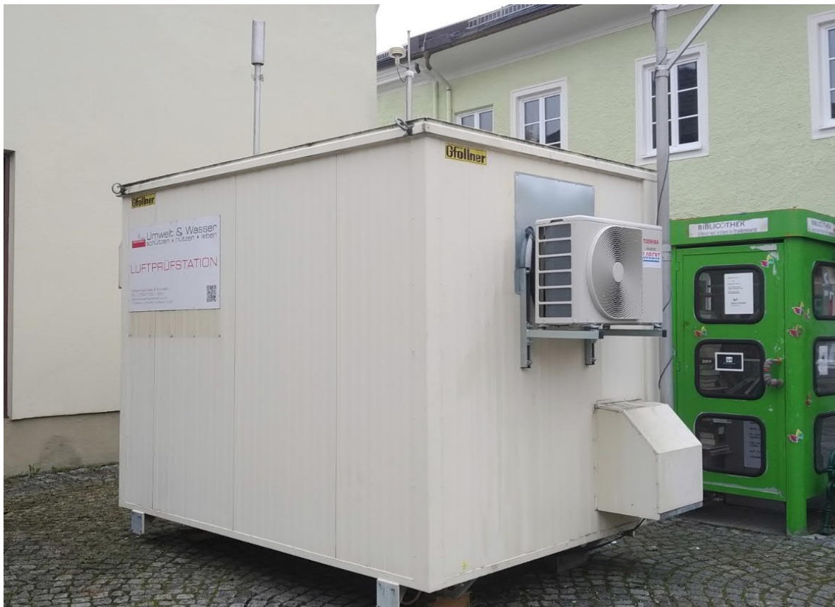
Abbildung 3: Messstelle S178 in südwestliche Richtung (Aufnahmedatum: 14.10.2019)
