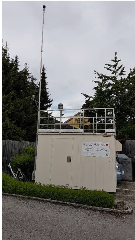
Station S156 Braunau Zentrum, Ansicht Richtung Norden, Aufnahme datum: 25.Mai 2021
