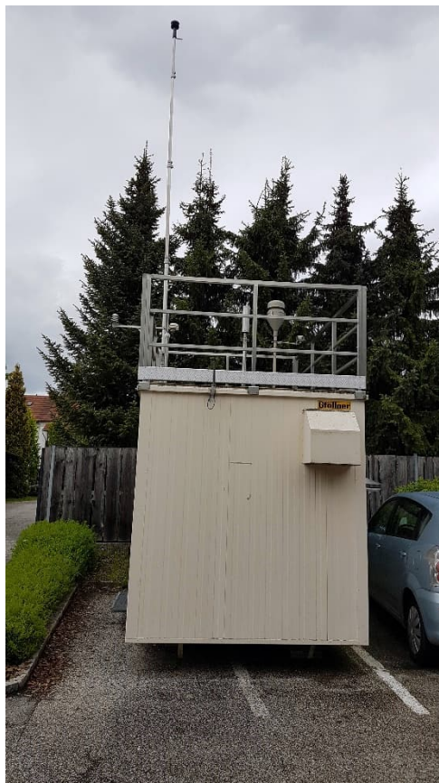
Station S156 Braunau Zentrum, Ansicht Richtung Westen, Aufnahme datum: 25.Mai 2021
