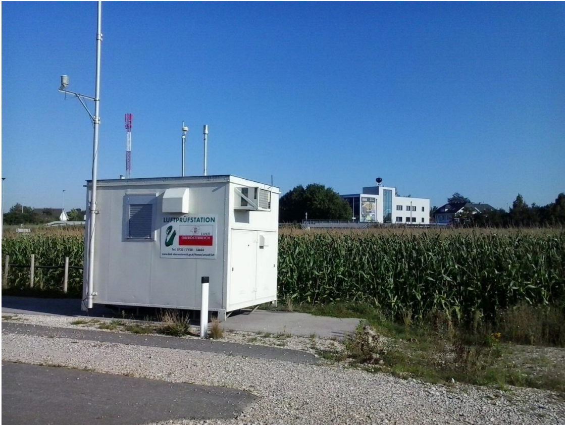
Abbildung 3: Messstelle S243 in nördliche Richtung (Aufnahmedatum: 29.8.2016)
