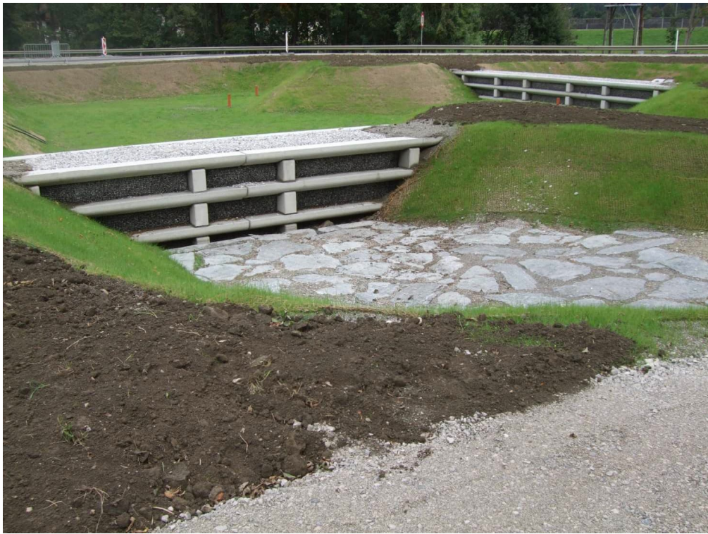
Motiv: Retentionsbecken Eisenbahnkreuz Bad Vigaun; Auftraggeber: Land Salzburg, Foto vom 25.09.2015
