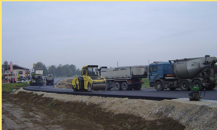
(Abb.: Asphaltierungsarbeiten Oktober 2010)
