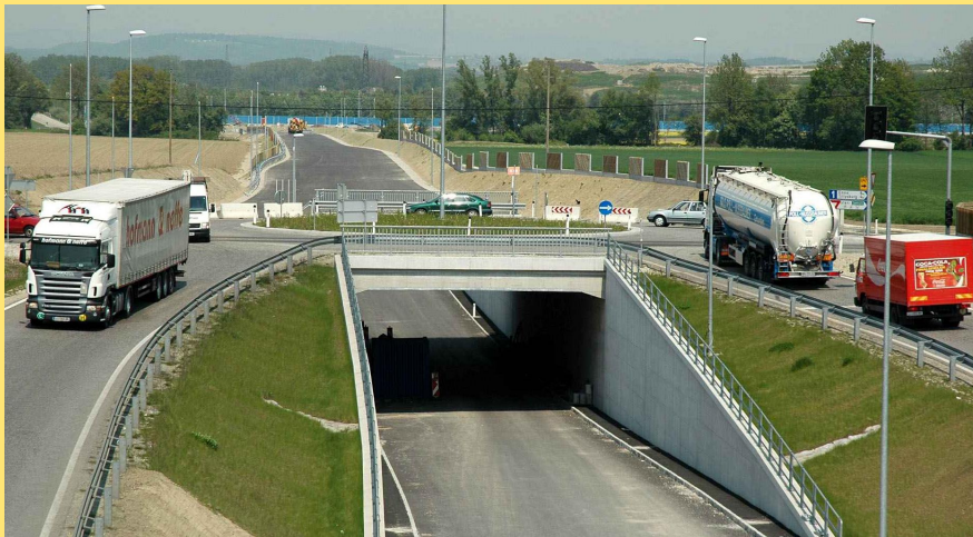
(Abb.: Unterführung Kreisverkehr Asten)
