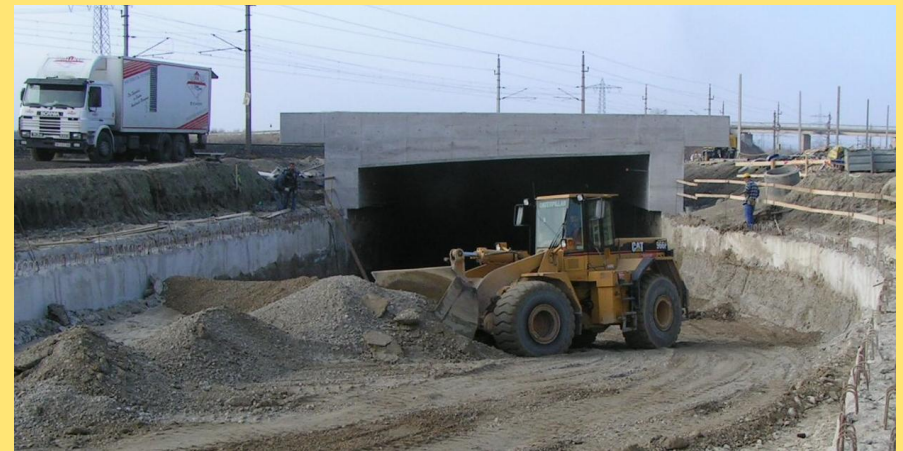
(Abb.: Bauarbeiten bei der Westbahnunterführung)
