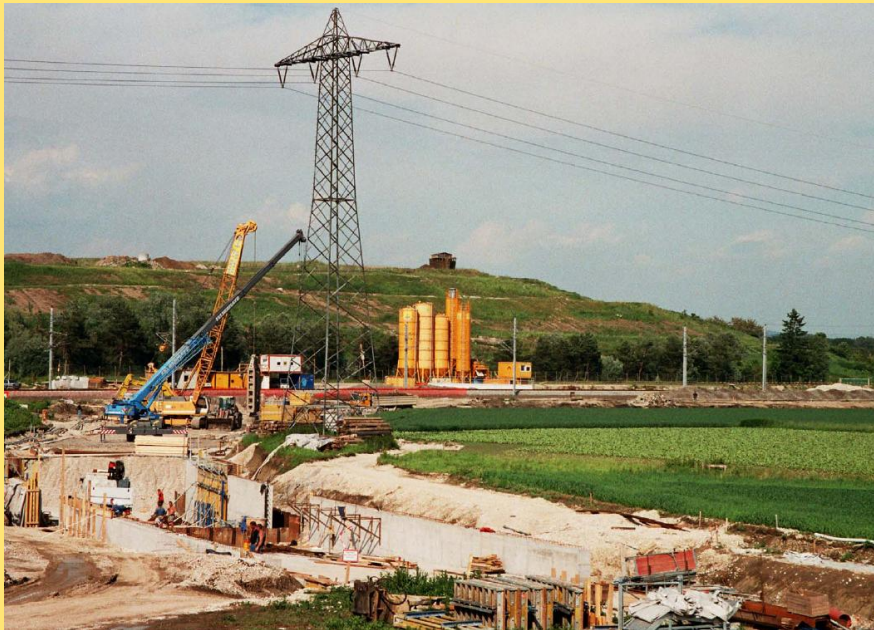
(Abb.: Bauarbeiten bei der „Weißen Wanne“ in Asten)
