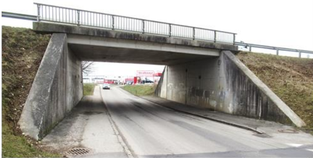
Unterführung Bahnhofstraße: Durchfahrt wird verbreitert
