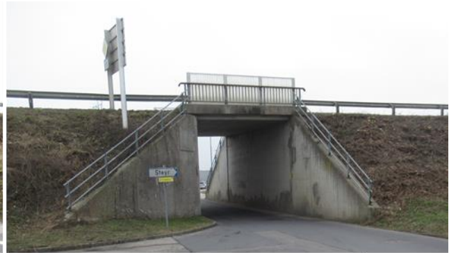
Unterführung Gewerbestraße: wird abgetragen und mit Geh- & Radweg neu gebaut
