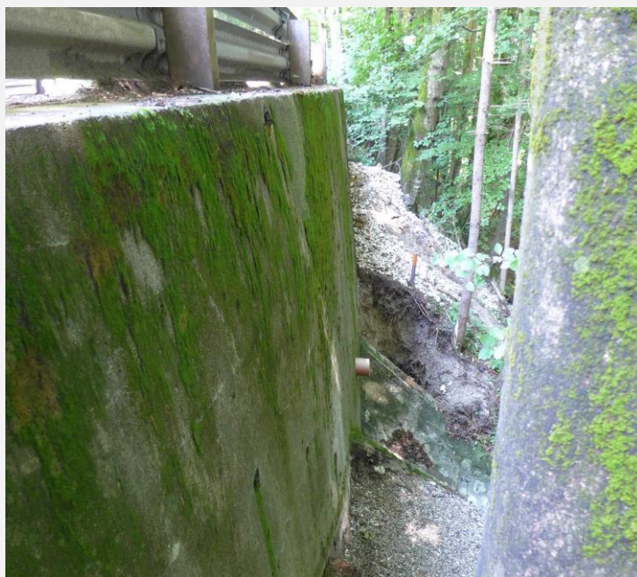
(Abb.: Bestandsaufnahme B120 – massive Betonmauern aus dem Jahr 1955)
