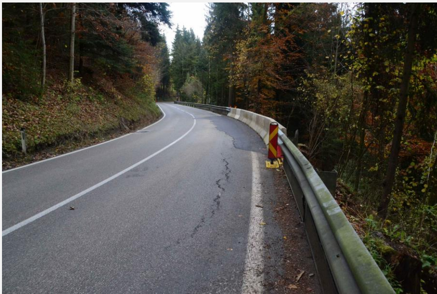
(Abb.: Bestandsaufnahme B120 im November 2014 – Sanierung Böschungsrutschung nach Starkregen)
