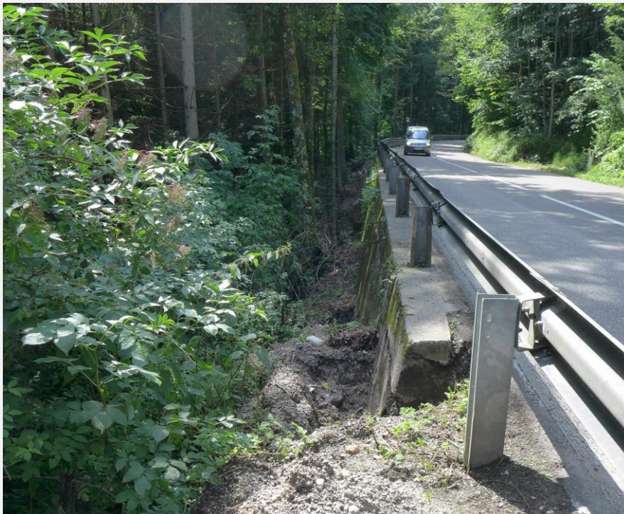
(Abb.: Bestandsaufnahme B120 – freigelegte Stützmauer)
