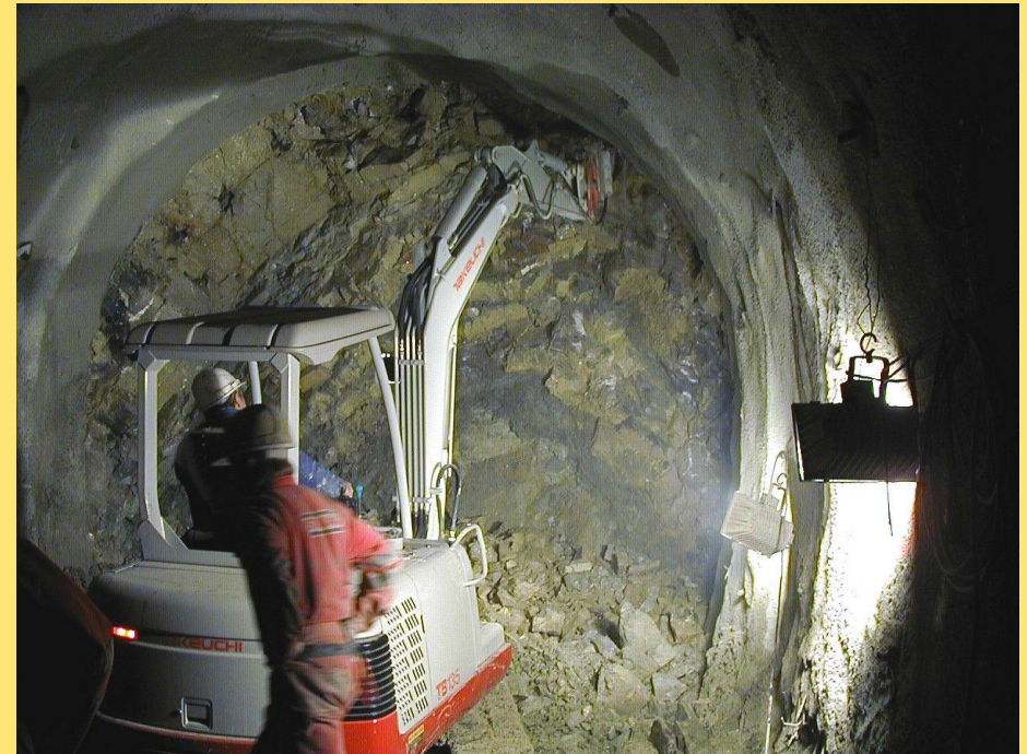
(Abb.: Tunnel Grünburg Erkundungsstollen)
