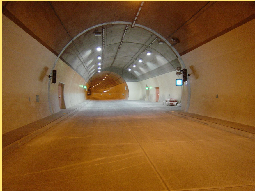
(Abb.: Tunnel Traunkirchen)
