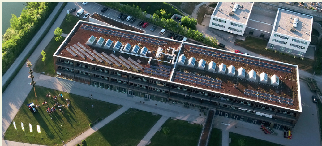
Photovoltaikanlage am Schuldach mit einer Fläche von rd. 388 m 2
