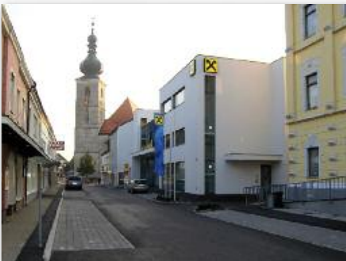
Abb.4: Ortskern von Sierning- Neustraße (Marktgemeinde Sierning, 2011)
